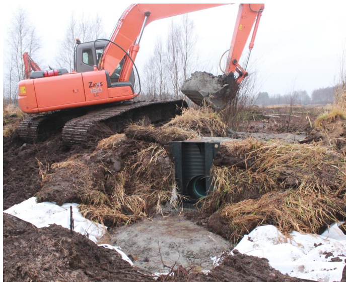
Virtaamansäätöpadon asennus Seinäjoen Kurjennevan kosteikolle Suomen riistakeskuksen Kotiseutukosteikko LIFE+ -hankkeessa v.2012.
