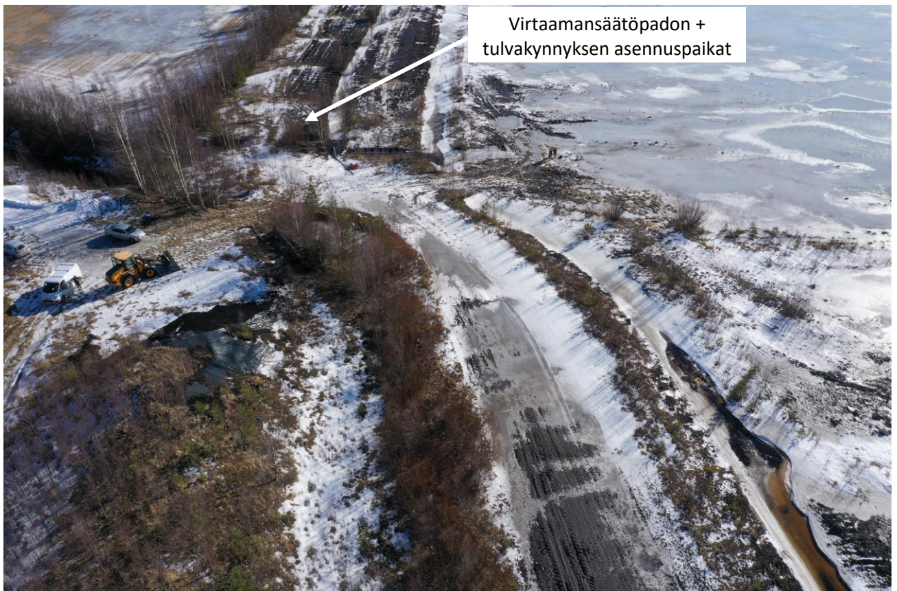
Kuva 5. Pienoisopterikuva osa-alueen 1 itäreunalta patolaitteiden asennuspaikalta 16.3.2020.
